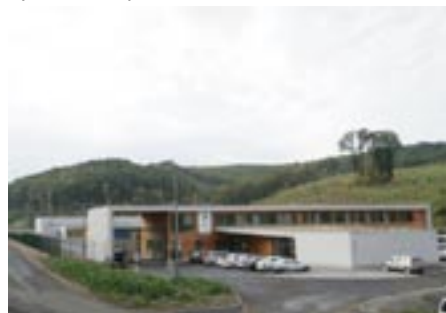
Vstupní objekt areálu úložiště
