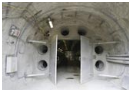
Ústí tunelu během výstavby
