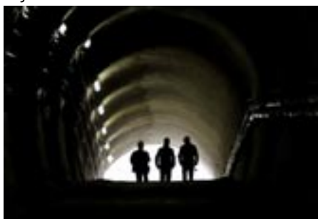
Budování podzemních tunelů
